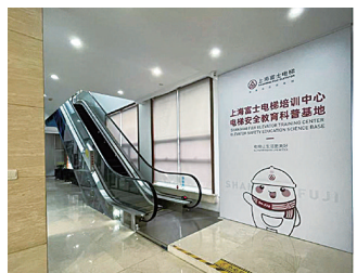
△ 自动扶梯类的教学梯,外挡板透明,可直接观察自动扶梯内部运行情况,直观了解自动扶梯运转原理。
